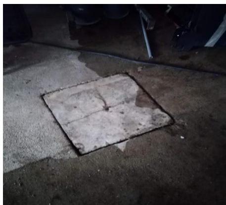
Figura 7 – Encaminhamento águas residuais resultantes das lavagens dos pavilhões (chorume) para a caixa recetora.
