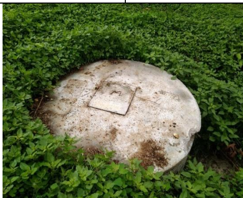
Figura 11 – Fossa central estanque da instalação.
